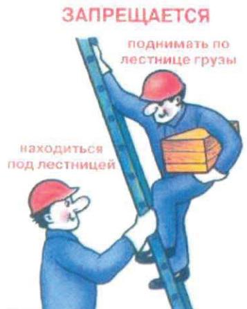
При работе с приставной лестницей на высоте более 1,8 м надлежит применять страховочную систему, прикрепляемую к конструкции сооружения или к лестнице (при условии закрепления лестницы к строительной или другой конструкции).
