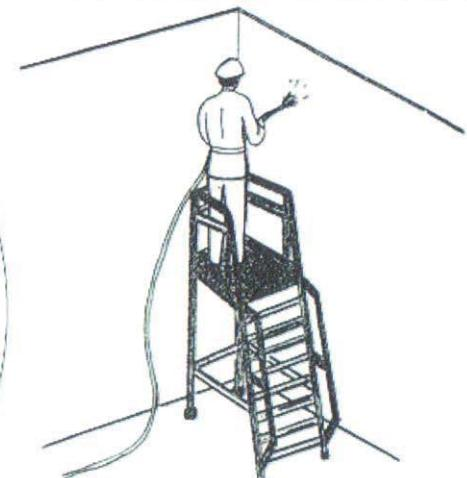
При работе на высоте с использованием электроинструмента необходимо использовать инвентарные приспособления!
